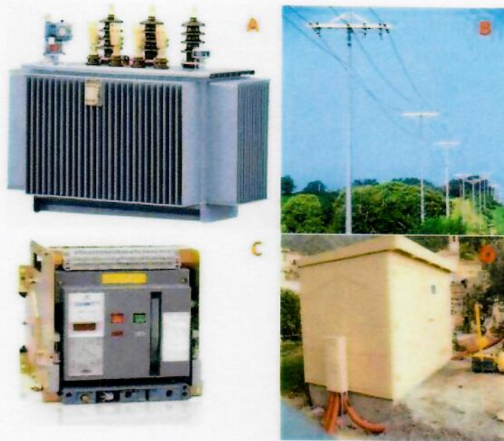
Figure 11: Image du illustrant le transformateur et matériels et équipements y afférents. (A): Transformateur 630 KVA. (B): Poteaux MT/BT. (C): Disjoncteur 1250 KVA. (D): Loge du transformateur.
